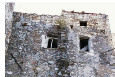
Muratura costituita da scapoli eterogenei e zeppe in laterizio di dimensioni variabili senza corsi evidenti. La tessitura è molto irregolare con frequenti sostruzioni in laterizio e abbondanti giunti in malta impiegati come regolarizzazione dei singoli elementi.
