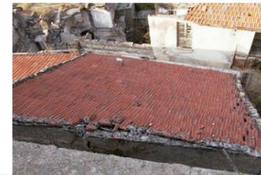
Nel XIX secolo, dismesso l'uso delle coperture a volta estradossata in quanto bisognose di una continua manutenzione, sono stati introdotti i tetti a falda, impostati su muri in pietra, di spessore più contenuto rispetto ai muri inferiori, o su murature in mattoni forati.
