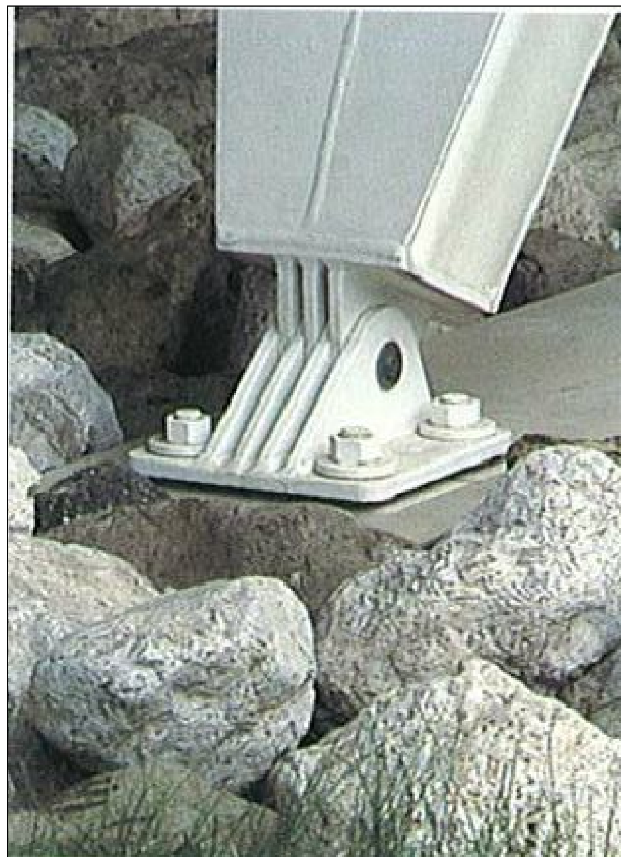
Ancoraggio della copertura
