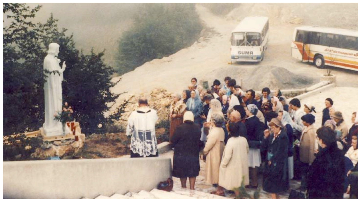
1980 Sbancamento del crinale per la realizzazione del Piazzale del Santuario
