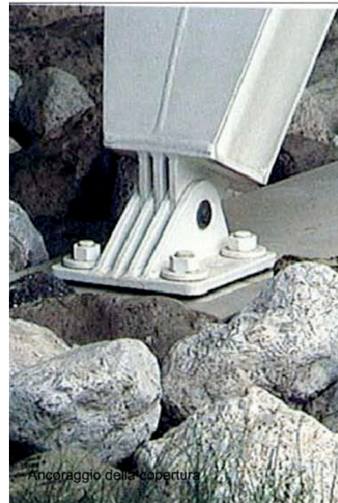
Giunto a cerniera della copertura
