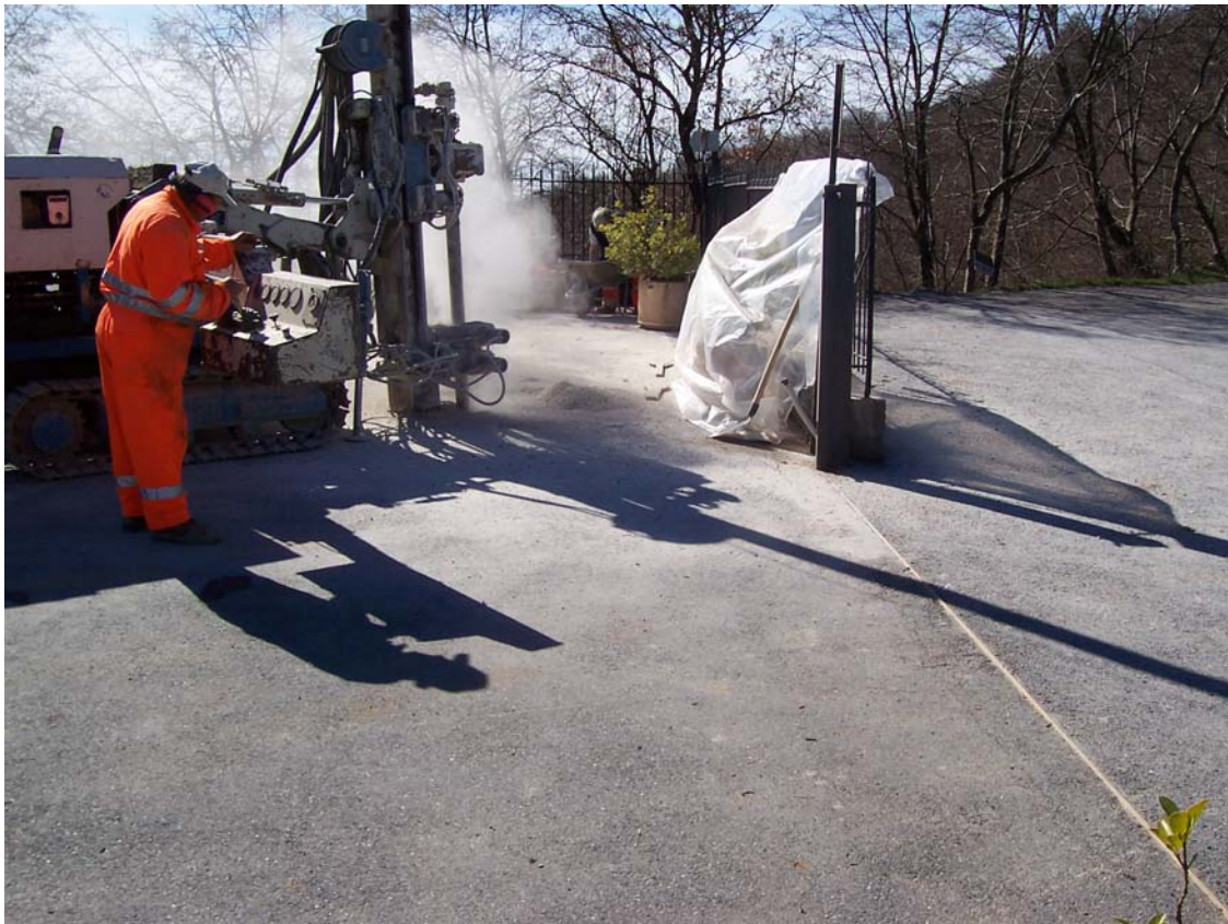
FOTO 2 – Ubicazione sondaggio S1
