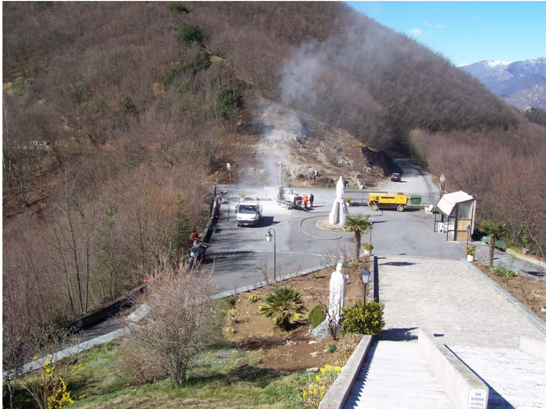
FOTO 1 – Vista generale dell' area di sedime
