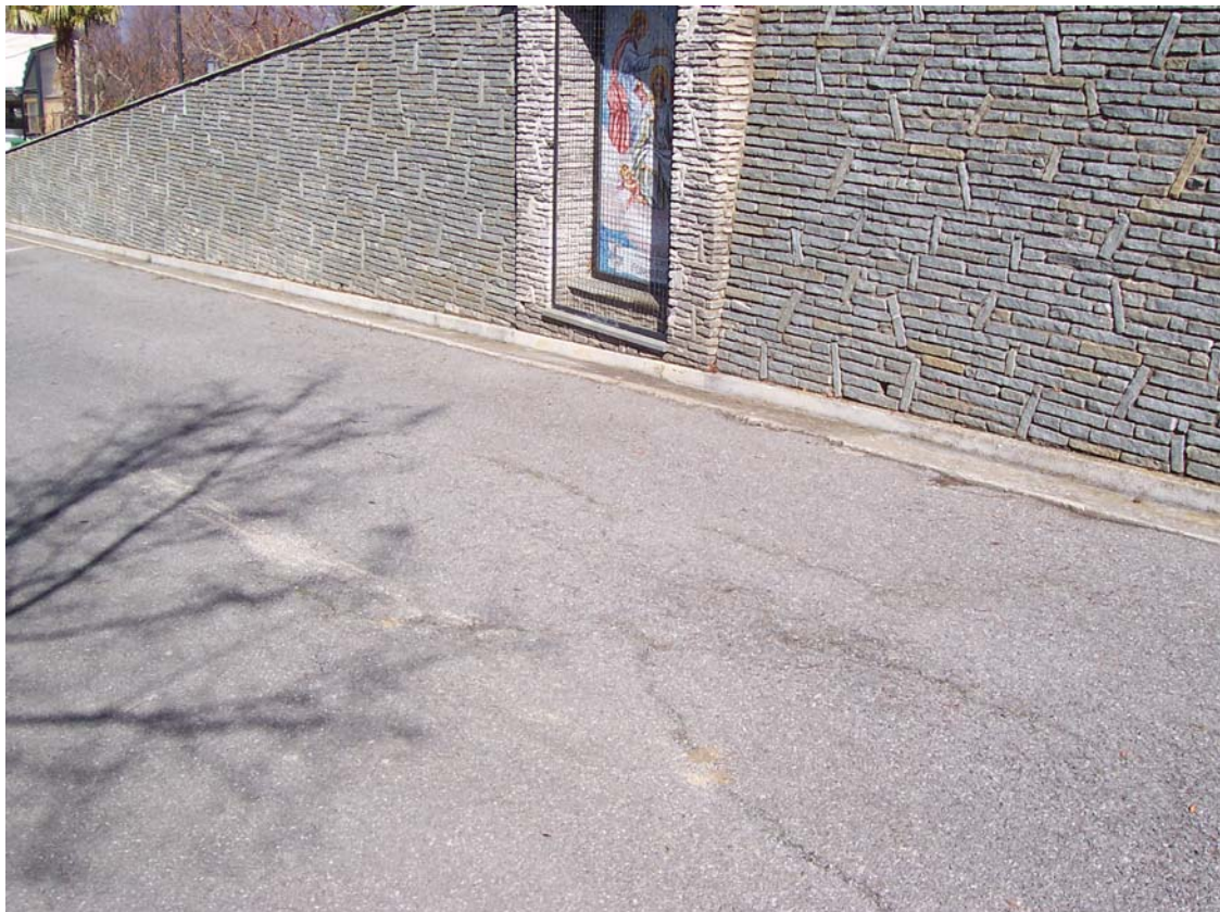
FOTO 4 – Ubicazione sondaggio S3
