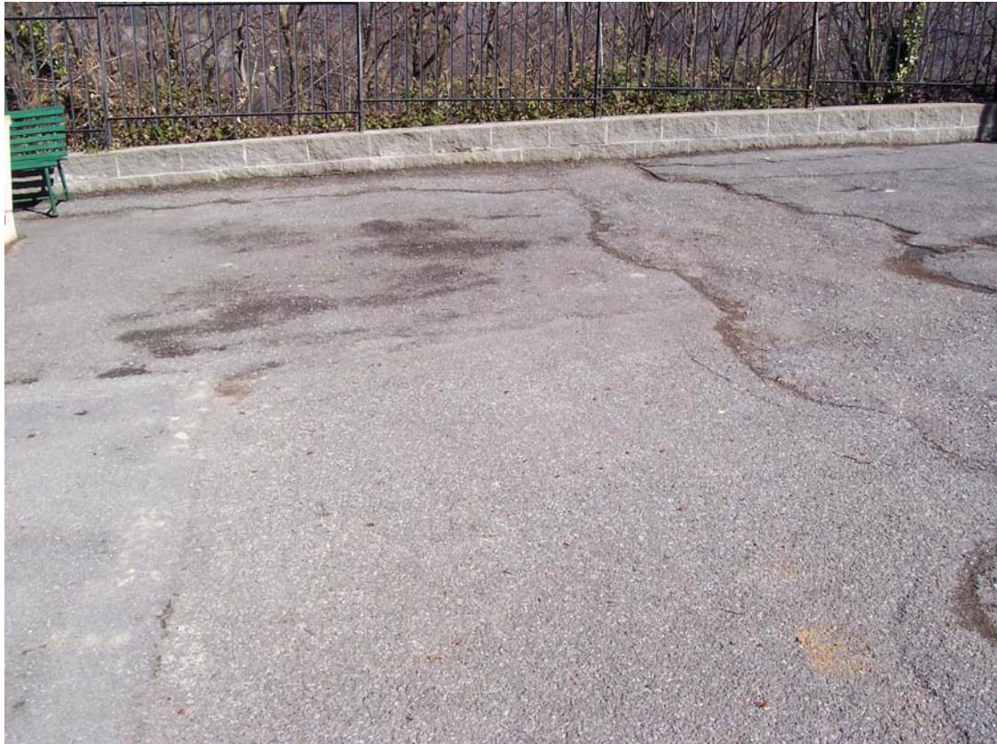
FOTO 3 – Ubicazione sondaggio S2
